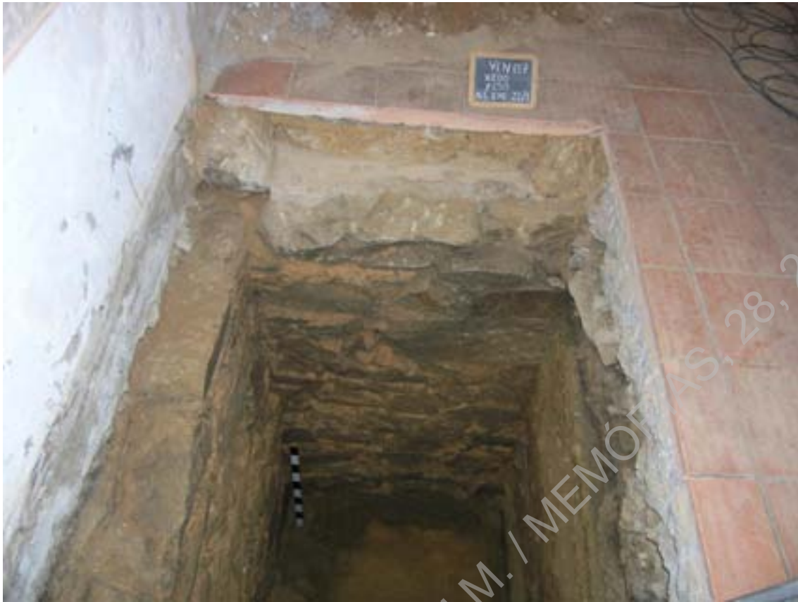
Foto 21 – Alçado Este da sondagem X203 Y247.248.
