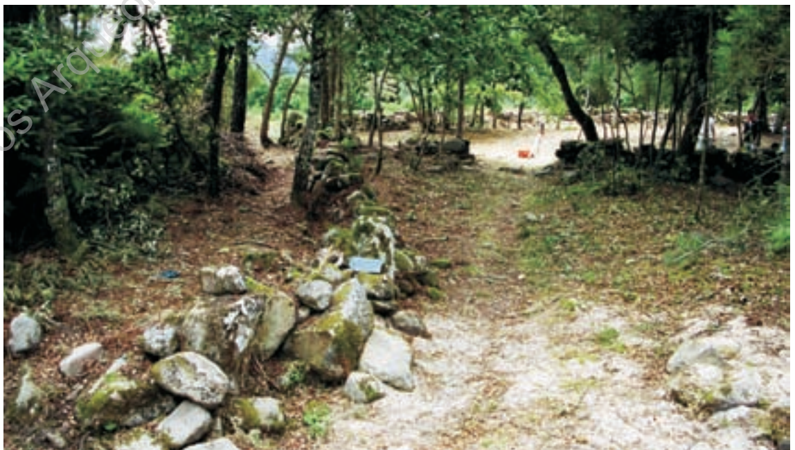
Foto 2 Pormenor de muro no acesso norte ao Adro Velho
