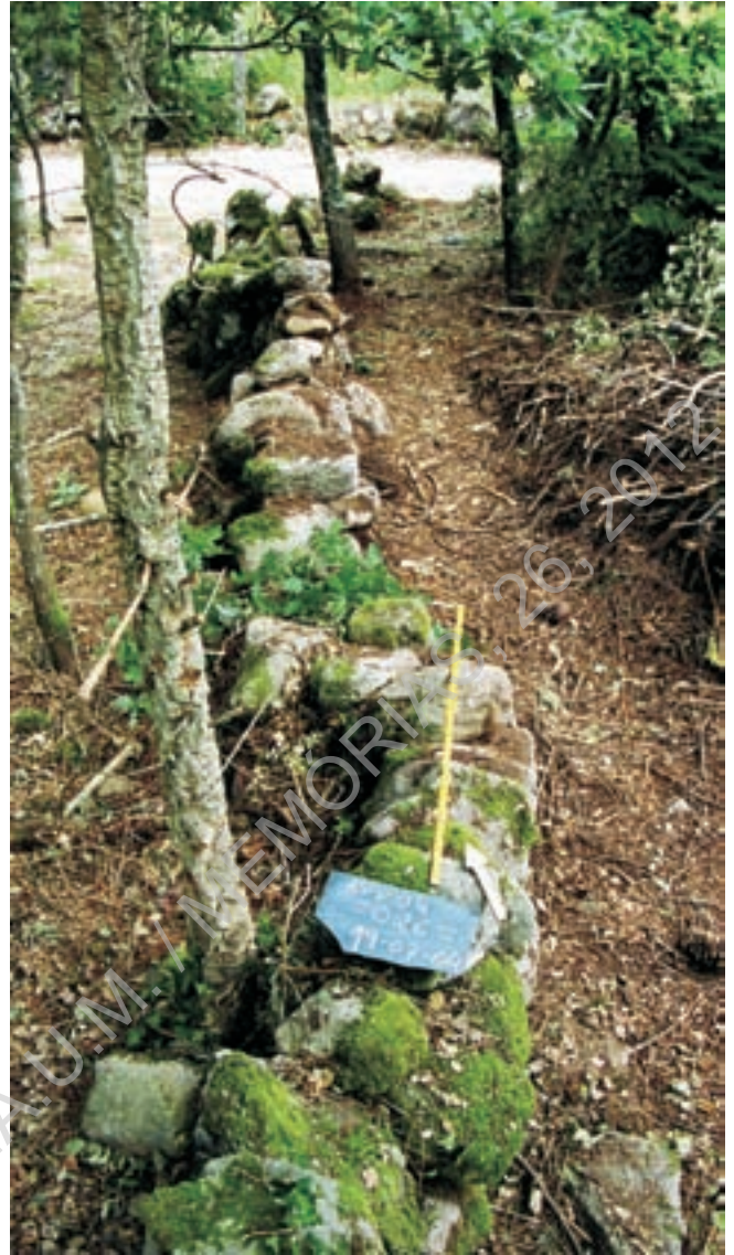
Foto 9 Muro apêndice no lado norte
