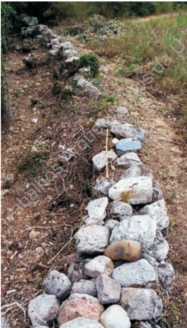
Foto 6 Pormenor do muro perimetral do Adro Velho
