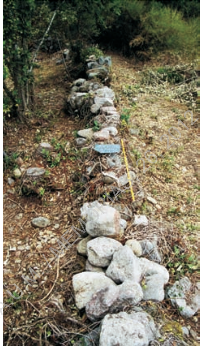
Foto 5 Muro perimetral do Adro Velho, lado poente
