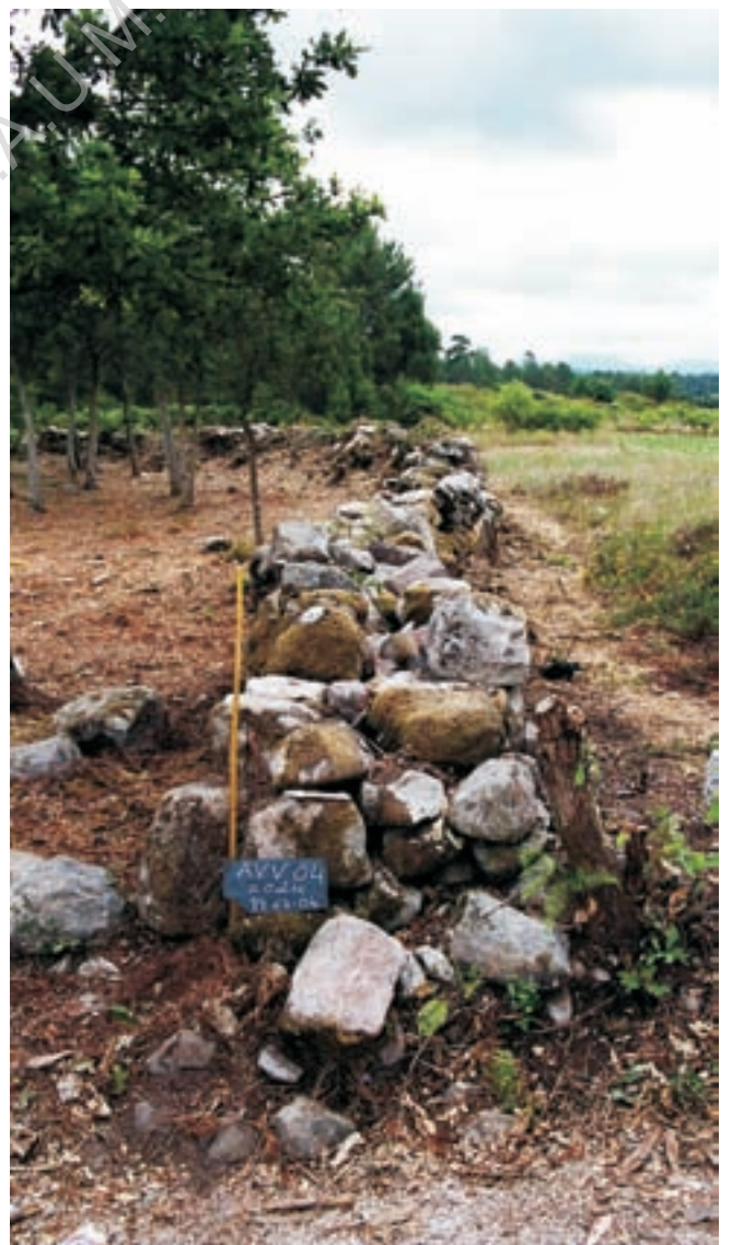
Foto 8 Pormenor do muro no lado sul
