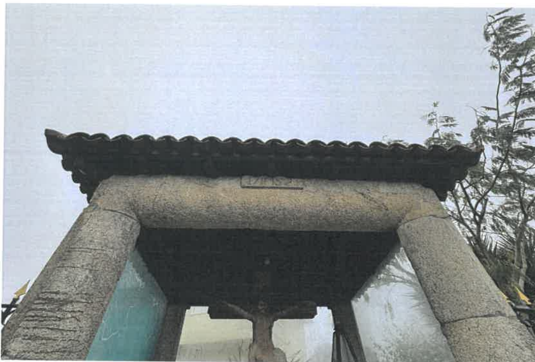
Foto n.º 6 – Pormenor da cobertura
