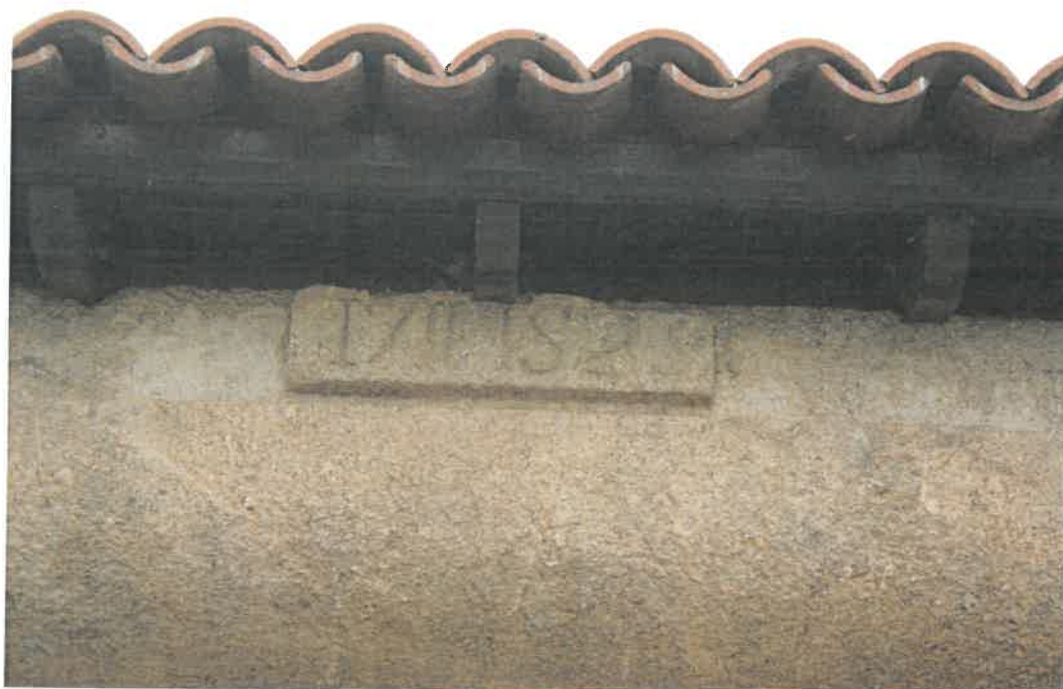
Foto n.º 7 – Pormenor da cartela com inscrição junto à cobertura.
