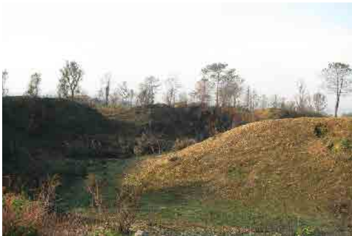
Foto n.º 23 – Vista do fosso na vertente Sul, Forte do Tuído.
