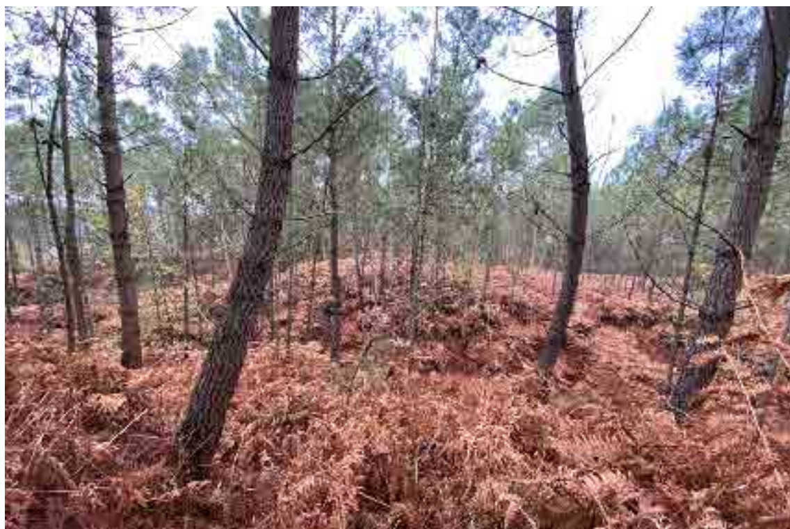
Foto n.º 34 – Vista geral de revelim, na vertente NO do Forte de S. Francisco.
