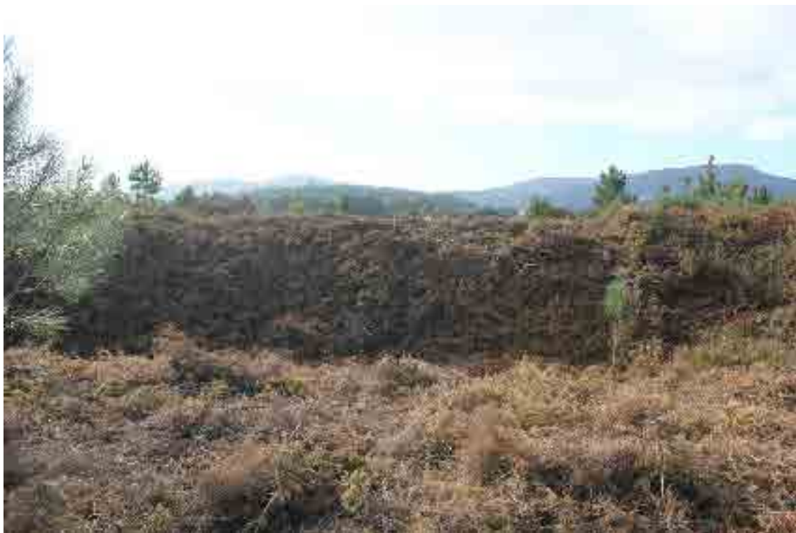
Foto n.º 3 – Esplanada do fosso exterior voltada a sul, Forte de S. Jorge (Silva).
