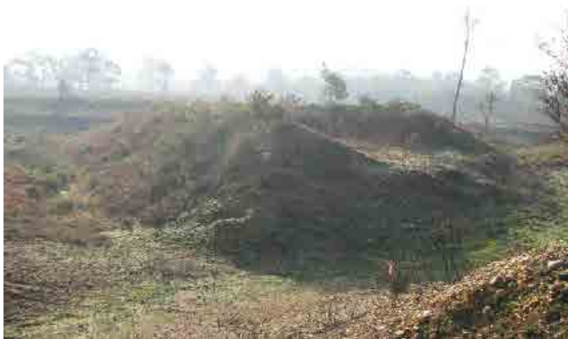
Foto n.º 28 – Vista geral do fosso, caminho coberto que o circunscreve e revelim, Forte do Tuído.
