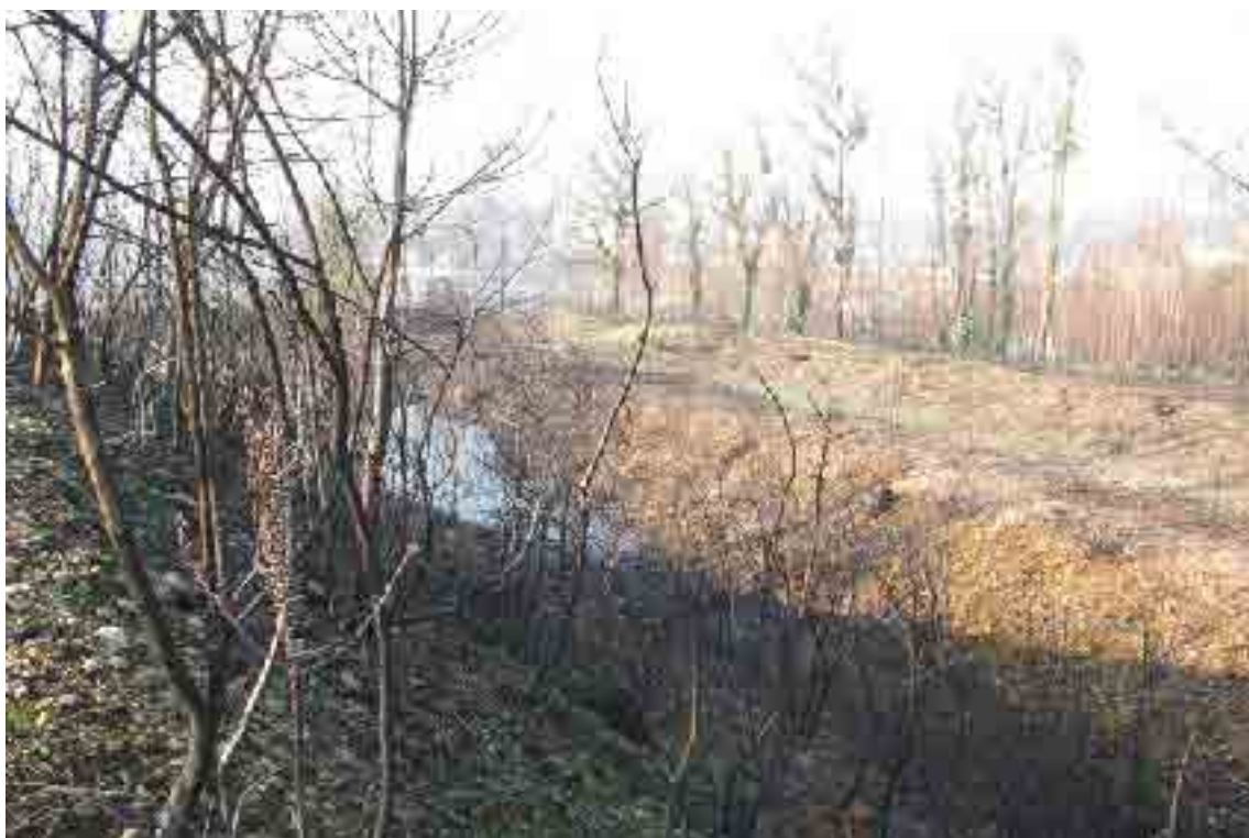
Foto n.º 26 – Vista do caminho coberto do Forte do Tuído.
