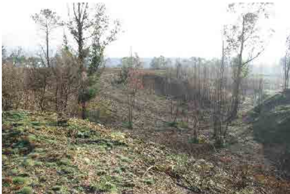
Foto n.º 27 – Vista geral das esplanadas e fosso exterior do Forte do Tuído.
