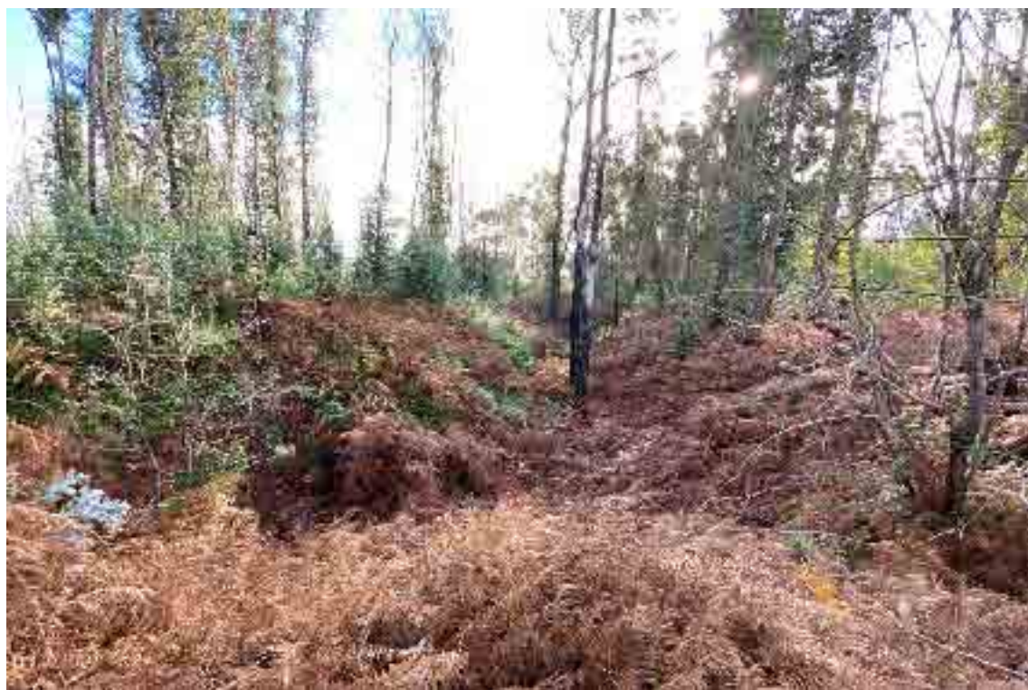
Foto n.º 15 – Vista correspondente ao fosso exterior voltado a Este, Forte S. Luíz Gonzaga.
