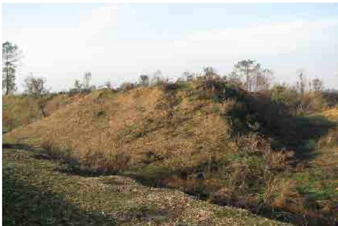
Foto n.º 20 – Vista do ângulo do baluarte do reduto, Forte do Tuído.
