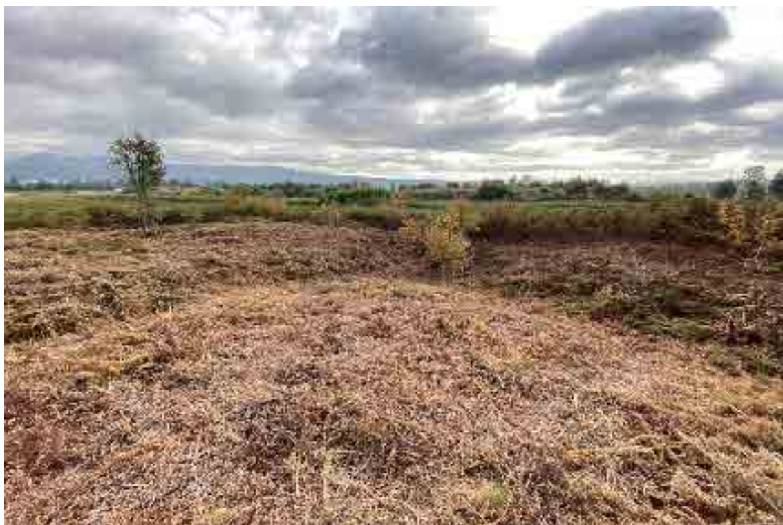
Foto n.º 45 – Vista do fosso a partir do reduto, para NE, do Forte de Belém.
